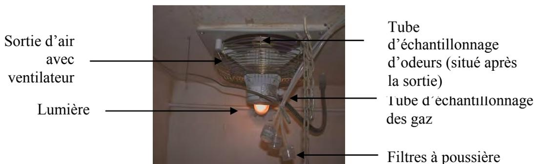
**Figure 12. Localisation des instruments d'échantillonnage**
