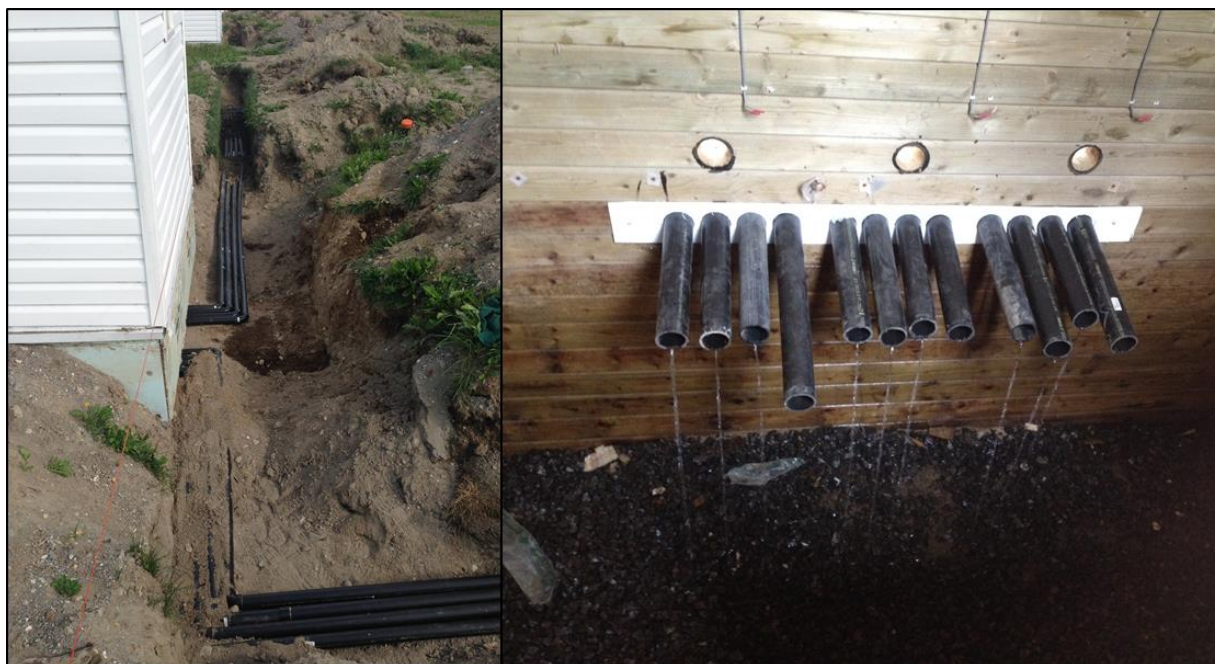
Figure 30: Connexion des drains aux cabanons pour récolter les eaux de chaque sous-parcelle
