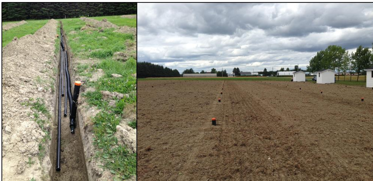
Figure 29: Installation des avaloirs et drains agricole (quatre réseaux indépendants par parcelles principales)
