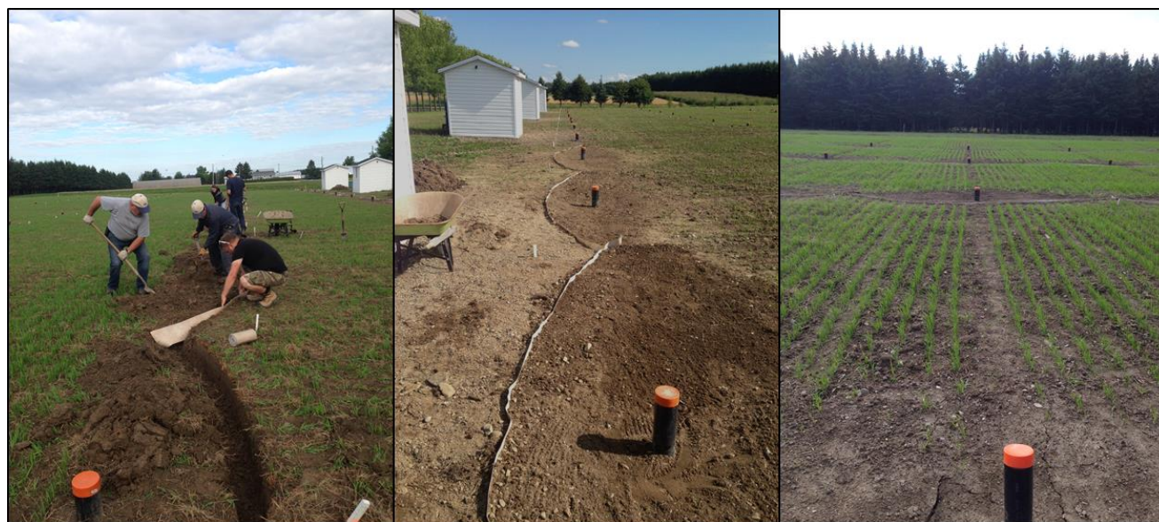
Figure 31: Installation des membranes d'étanchéité pour former les avaloirs de chaque sous-parcelle
