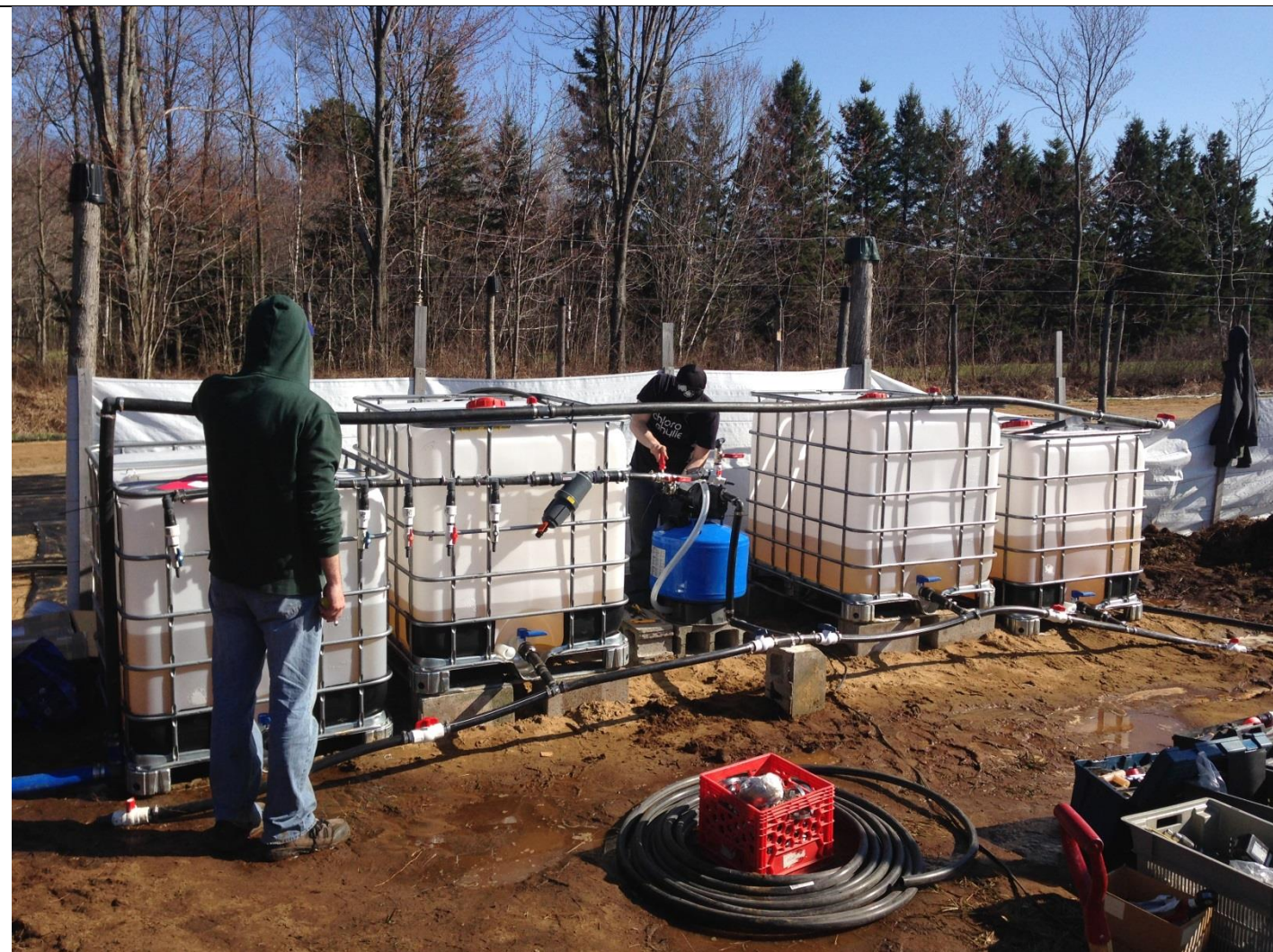
Photographie 2. Mise en place du système d'irrigation.
