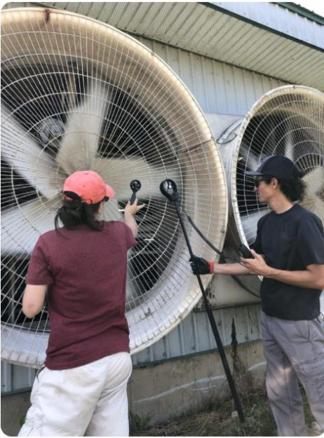
Mesure du débit d'air des ventilateurs d'une des fermes participantes.
