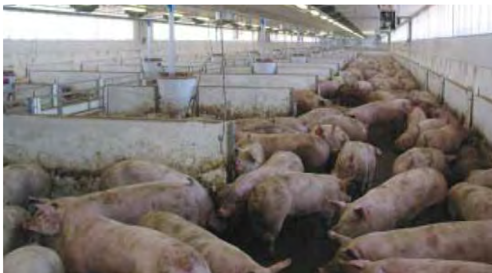
Figure 16. Salle avec station de tri dans un bâtiment conventionnel.
