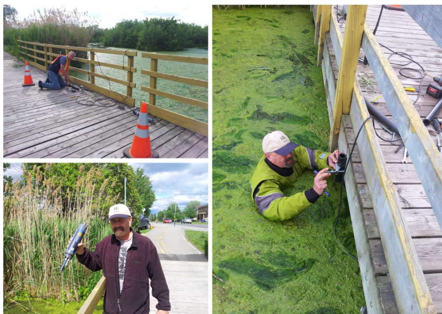
Figure 4. Installation des équipements à la station du ruisseau du Grand Marais.
