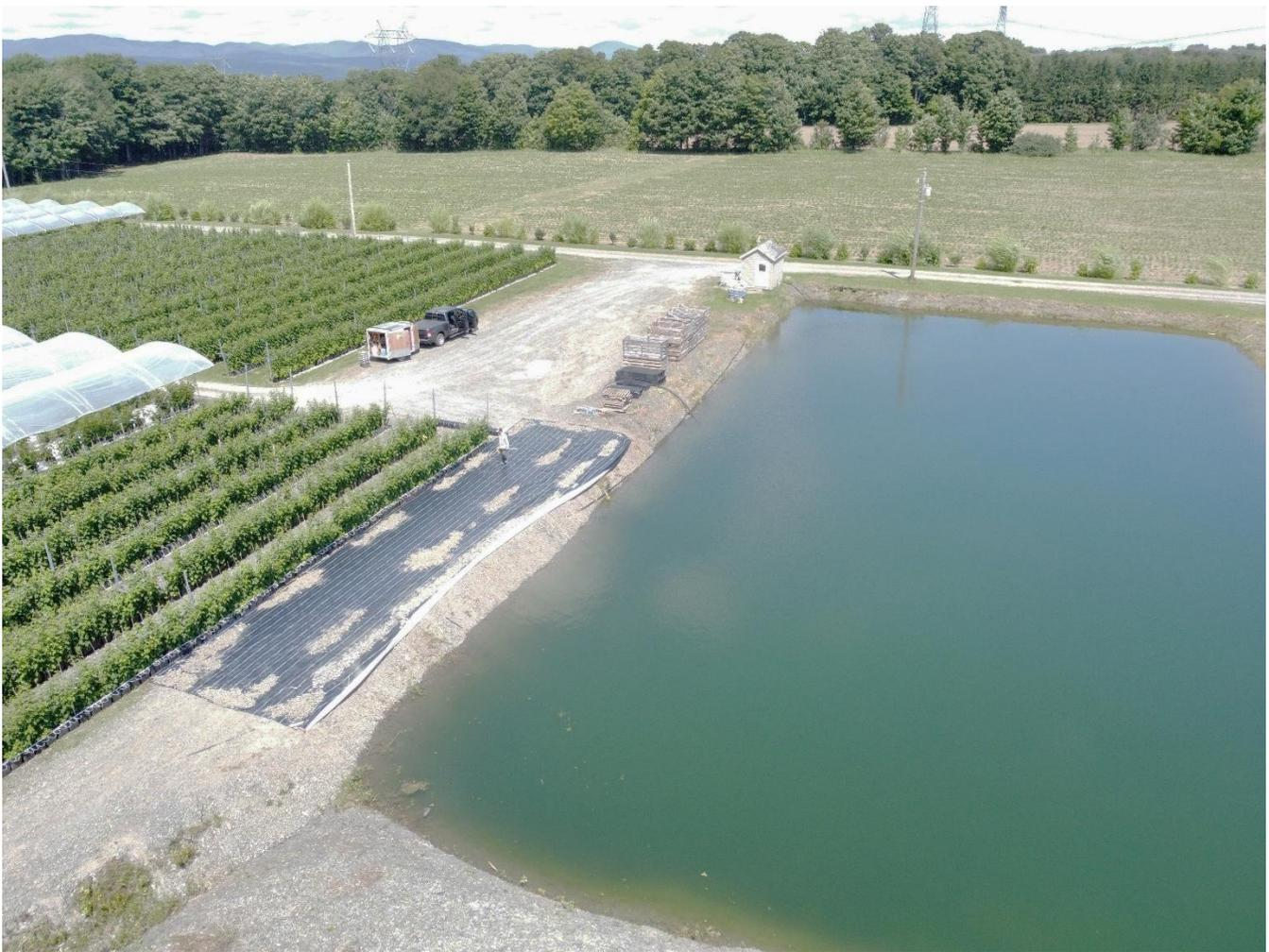
Figure 7. Installation de la toile Aquamat en bordure de l'étang d'irrigation au site FJPP.
