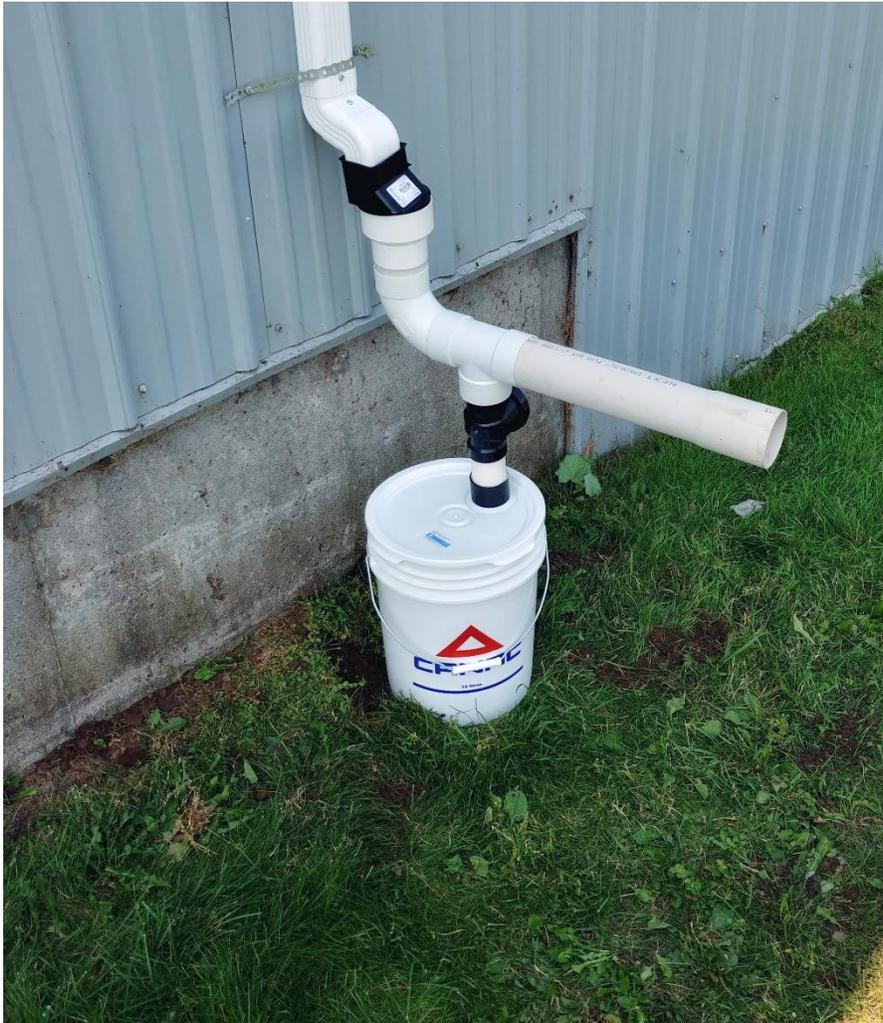
Figure 8. Dispositif d'échantillonnage utilisé en 2021 pour l'eau de rinçage.
